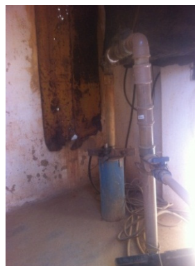
Vista interna do poço 1
