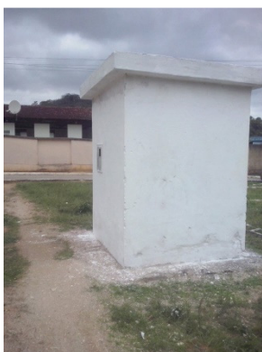
Vista externa do poço
