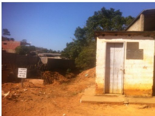
Vista externa do poço 1
